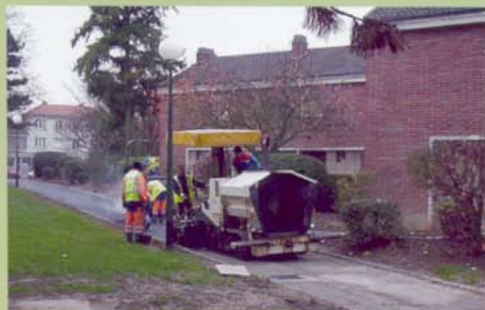
Les travaux sont en cours
