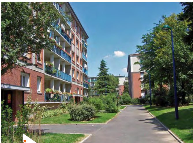
La réhabilitation des pièces humides de 400 logements de la Cité Trivaux La Garenne commence en janvier.
